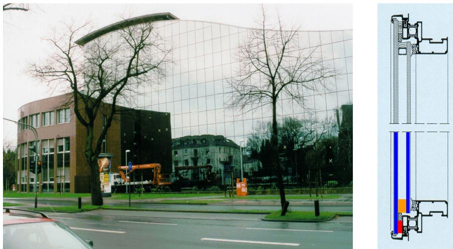
Abbildung 1: Fassadensystem Schüco SG 50 N, Detail der Konstruktion; blau: Glasscheiben, orange: Isolierglasverbund, rot: strukturelle Silikon-Klebung.
