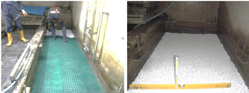
Abbildung 3: Einbau der untersten beiden Filterschichten am 09.07.2015 (Betriebsphase II)
