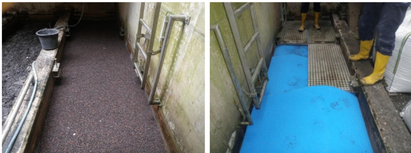
Abbildung 4: Einbau der oberen Filterschicht und der abschließenden Filtermatte am 09.07.2015 (Betriebsphase II)
