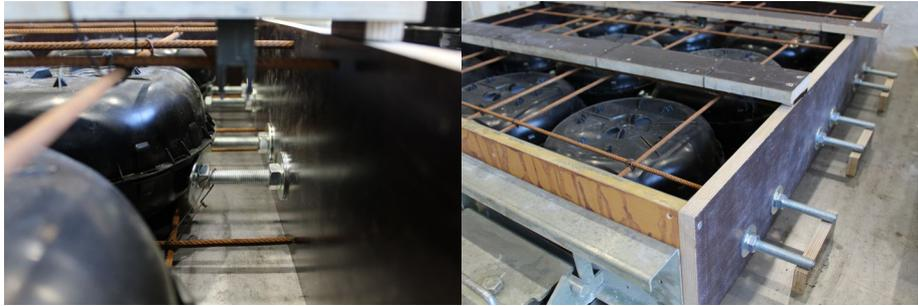
Abb. 3.23: Verankerung der Hohlkörper in der Schalung
