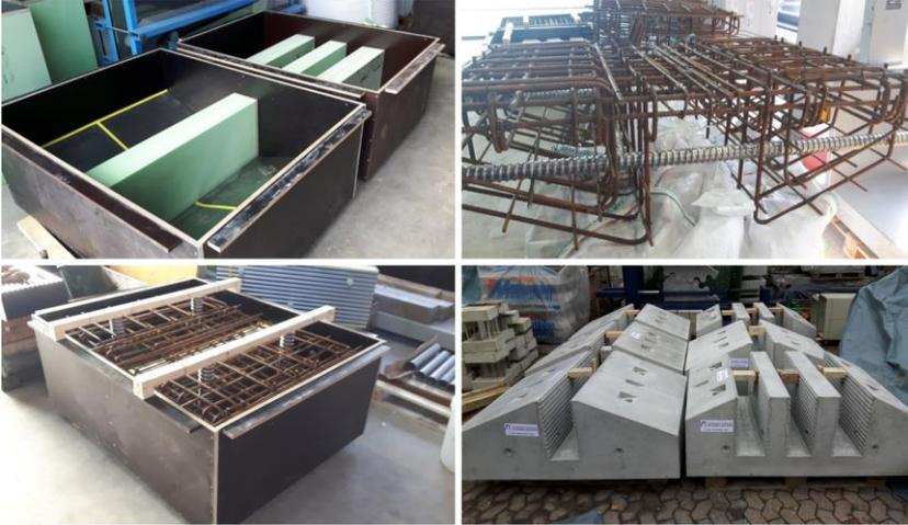
Abb. 7.33: Polystyrolelemente (oben links), Köcherbewehrung (oben rechts), Bewehrungskorb in Holzschalung (unten links), Köcherfundamente (unten rechts)
