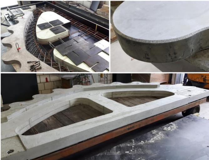
Abb. 7.36: Bewehrung Abrollhügel (oben links), Verzahnung mit Fase (oben rechts), Abrollhügel (unten)
