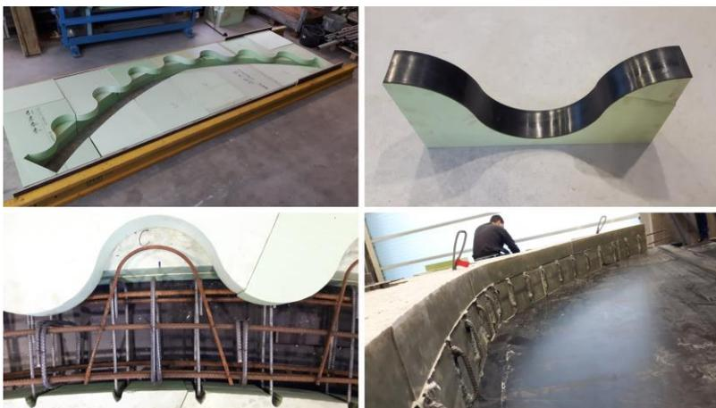
Abb. 7.34: Schalung (oben links), aufgeklebte Gummierung (oben rechts), Bügelbewehrung (unten links), Anschlussbewehrung (unten rechts)
